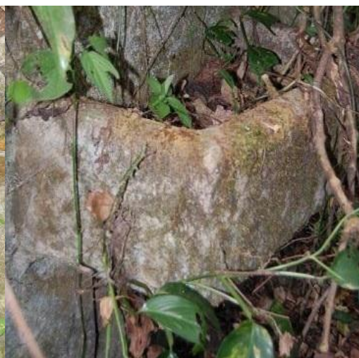
Figura 27. Pia da edificação.
