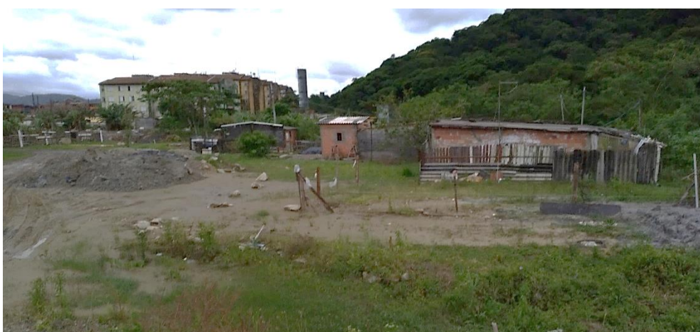
Figura 3-53: Vista geral da Vila CAIC, ocupações e deposição de material escavado, área lindeira
