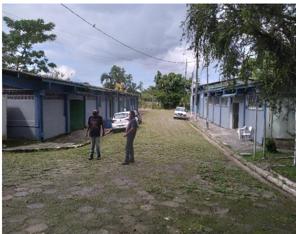
Figura 4-28: Vista geral dos dois prédios da área administrativa
