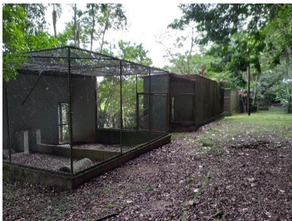
Figura 4-10: Vista geral da área dos recintos que abrigavam animais silvestres
