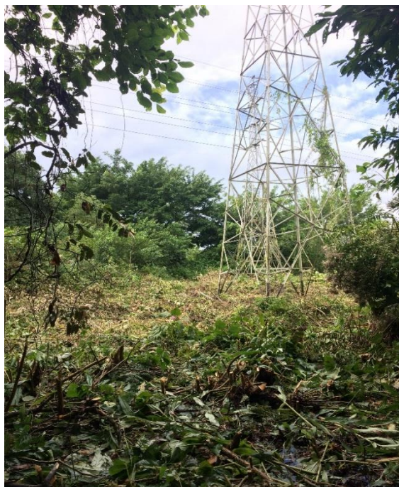
Figura 3-27: Vista da base, torre de transmissão, vegetação manejada para manutenção
